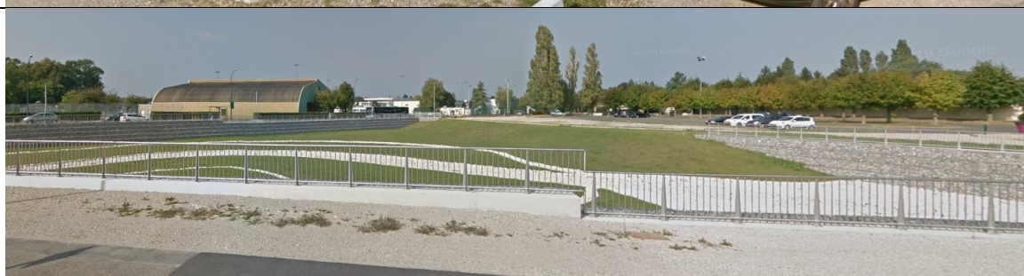
Bassin d'orage paysager – Vaux le Pénil
